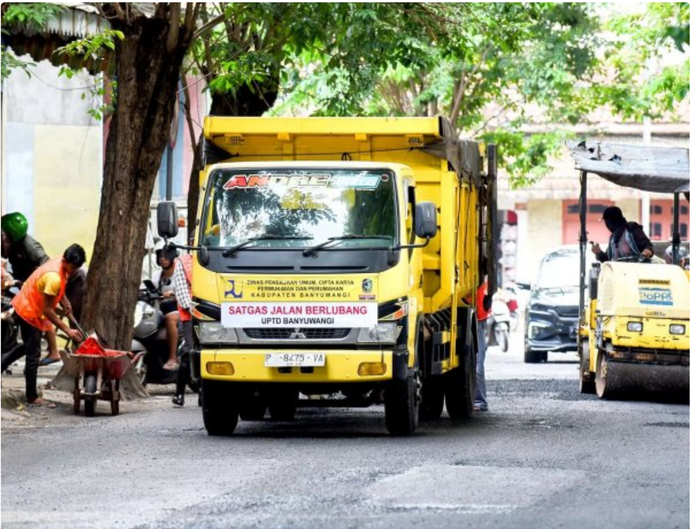
Tim Satgas Jalan Berlubang Dinas PU CKPP sedang menembel jalan berlubang di area jalan sayu wiwit menjelang Hari Raya Idul Fitri 1445 H
